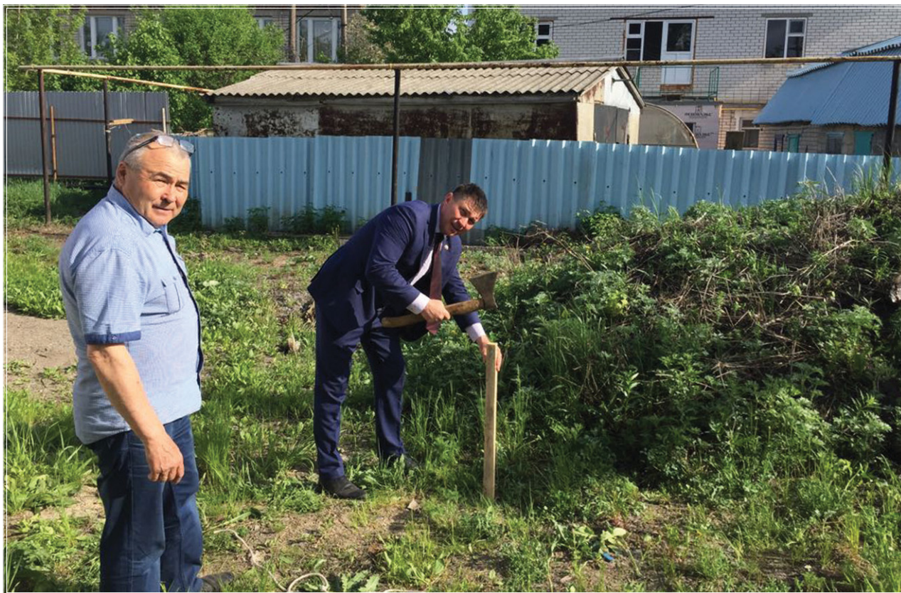
■ Забит первый колышек под строительство нового здания Нурлатского участка
